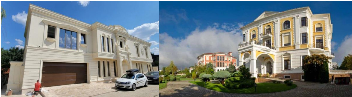
Exemple AȘA NU - Casă rezidențială construită în 2023 în Pipera, imitație stil neoclasic / British School București, construcție anii 2000
