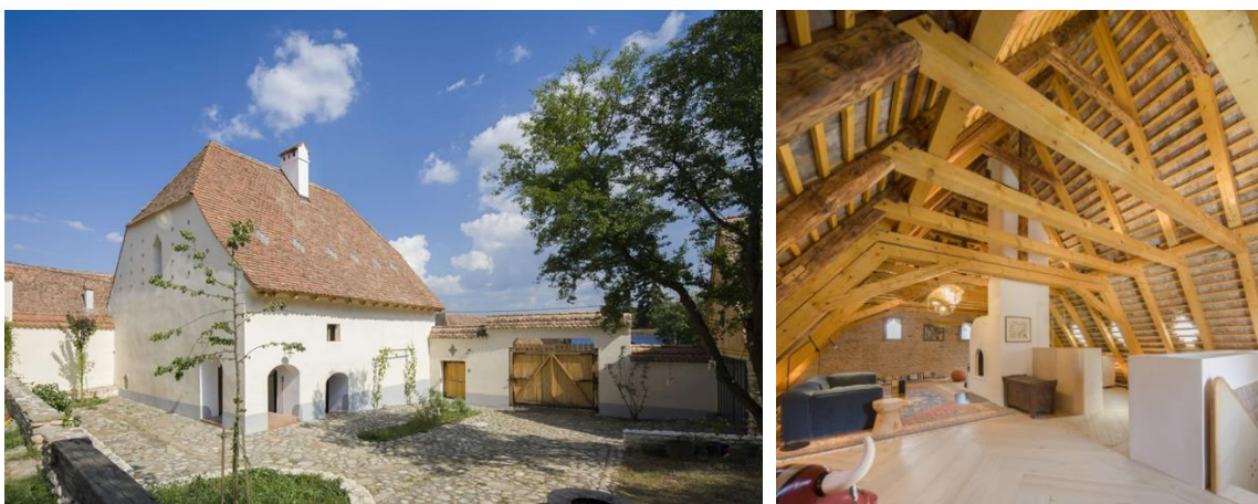
Casă tradițională, Viscri, JB Architects – transformarea podului în nivel de locuire cu păstrarea geometriei inițiale complet nealterate, imaginea casei tradiționale intactă
