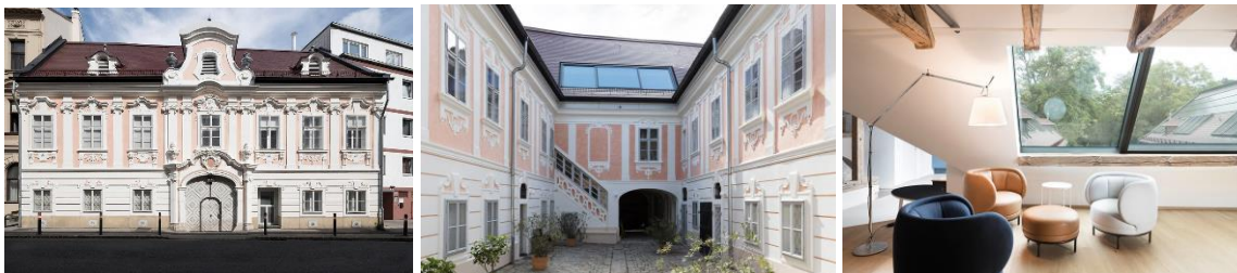
Topfelhaus Viena, Chameleon + Goldfish GmbH – ferestre contemporane vizibile doar din curtea interioară, păstrarea elementelor istorice de șarpantă vizibile în interior, nealterarea geometriei învelitorii
